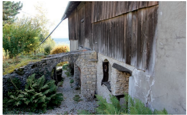
Ferme traditionnelle avec un pont de grange.
