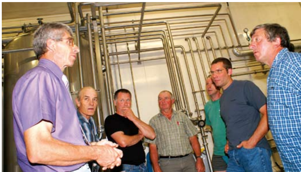
L'isolation du réseau de vapeur, un point relevé au cours du diagnostic à Orgelet.
