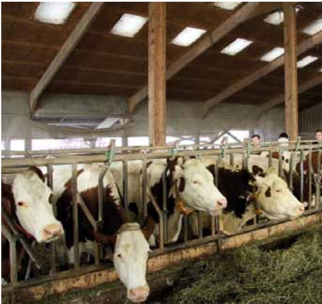
Un double plafond en bois triply est installé sur toute la surface du bâtiment et capte l'air chauffé par le soleil à travers le toit en fibrociment.
